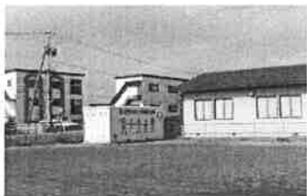
↑ 桜台小学校防災備蓄倉庫
