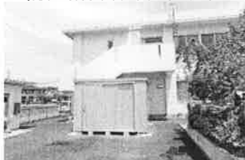
↑ 桜地区センター防災備蓄倉庫
